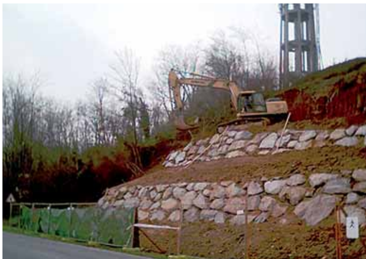
Sistemazione fronte franoso via V. Emanuele
